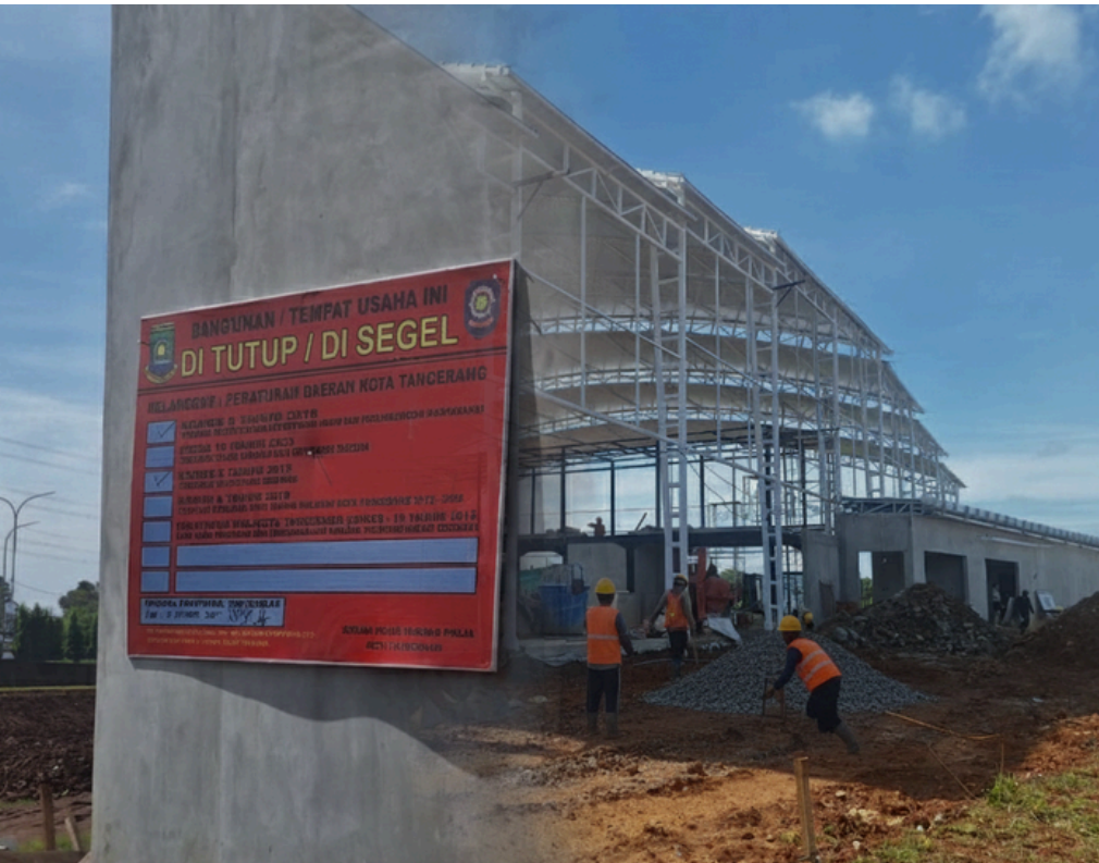
Bangunan proyek lapangan Padel di Kota Tangerang (Dok)
